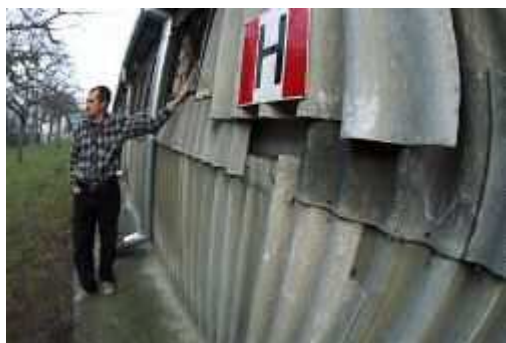
Rysunek 8 Ściana boczna budynku z płyt cementowo-azbestowych:
