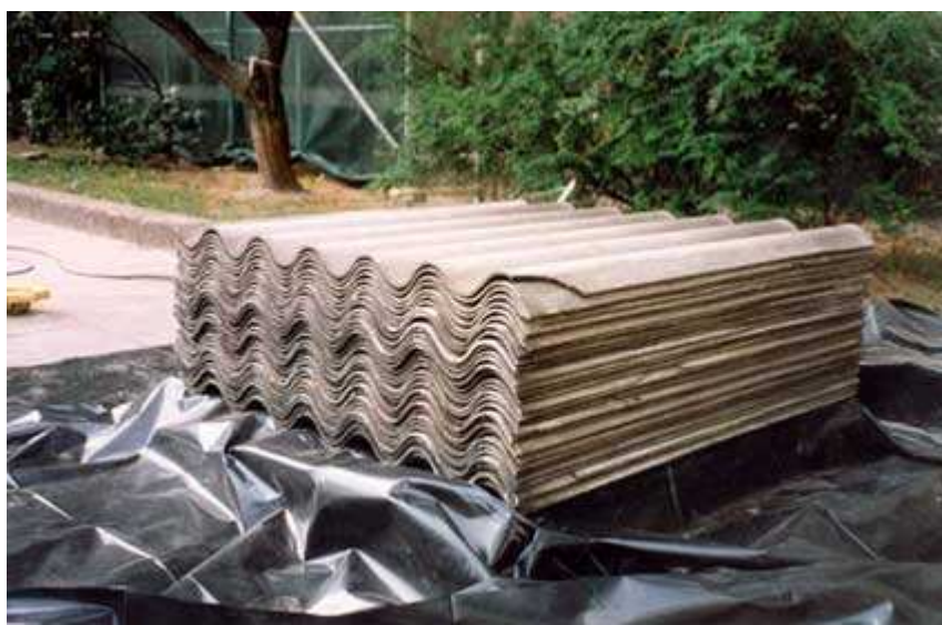
Rysunek 6 Przygotowanie wyrobów azbestowych do transportu:
