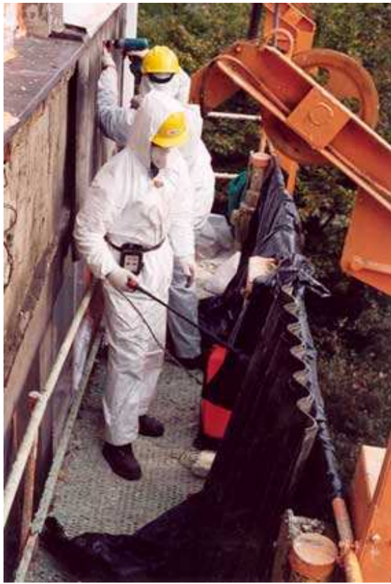
Rysunek 5 Usuwanie wyrobów azbestowych:
