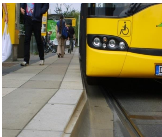
Rys. 9.8.2.1. Zalecane ukształtowanie krawędzi peronowej.
